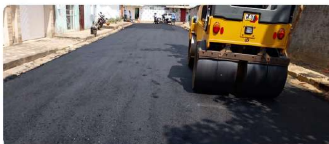
Tapa Buraco e Pavimentação Asfáltica
