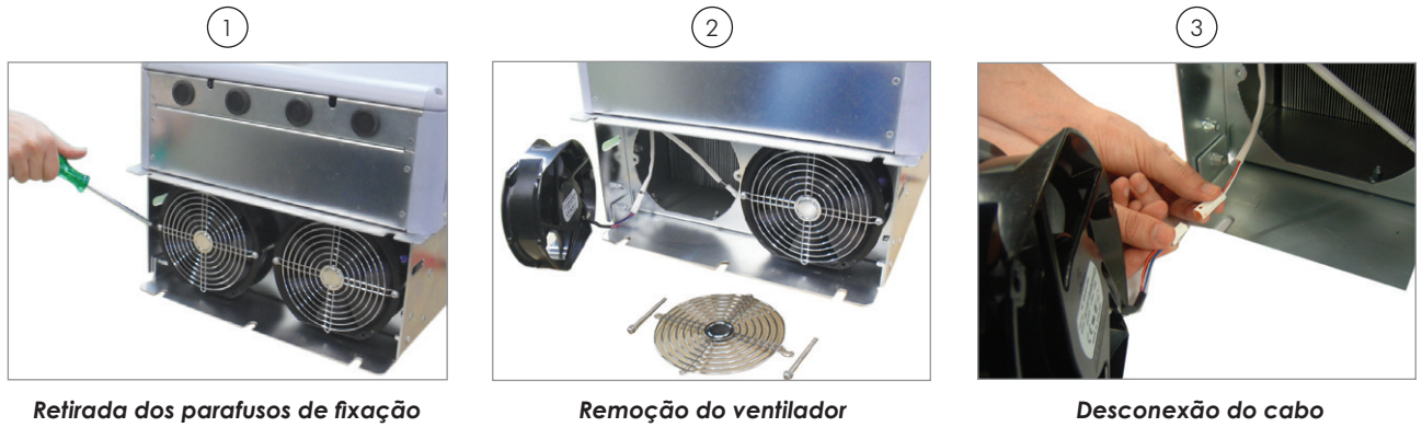
Figura 6.1 - Remoção do ventilador dos dissipadores
